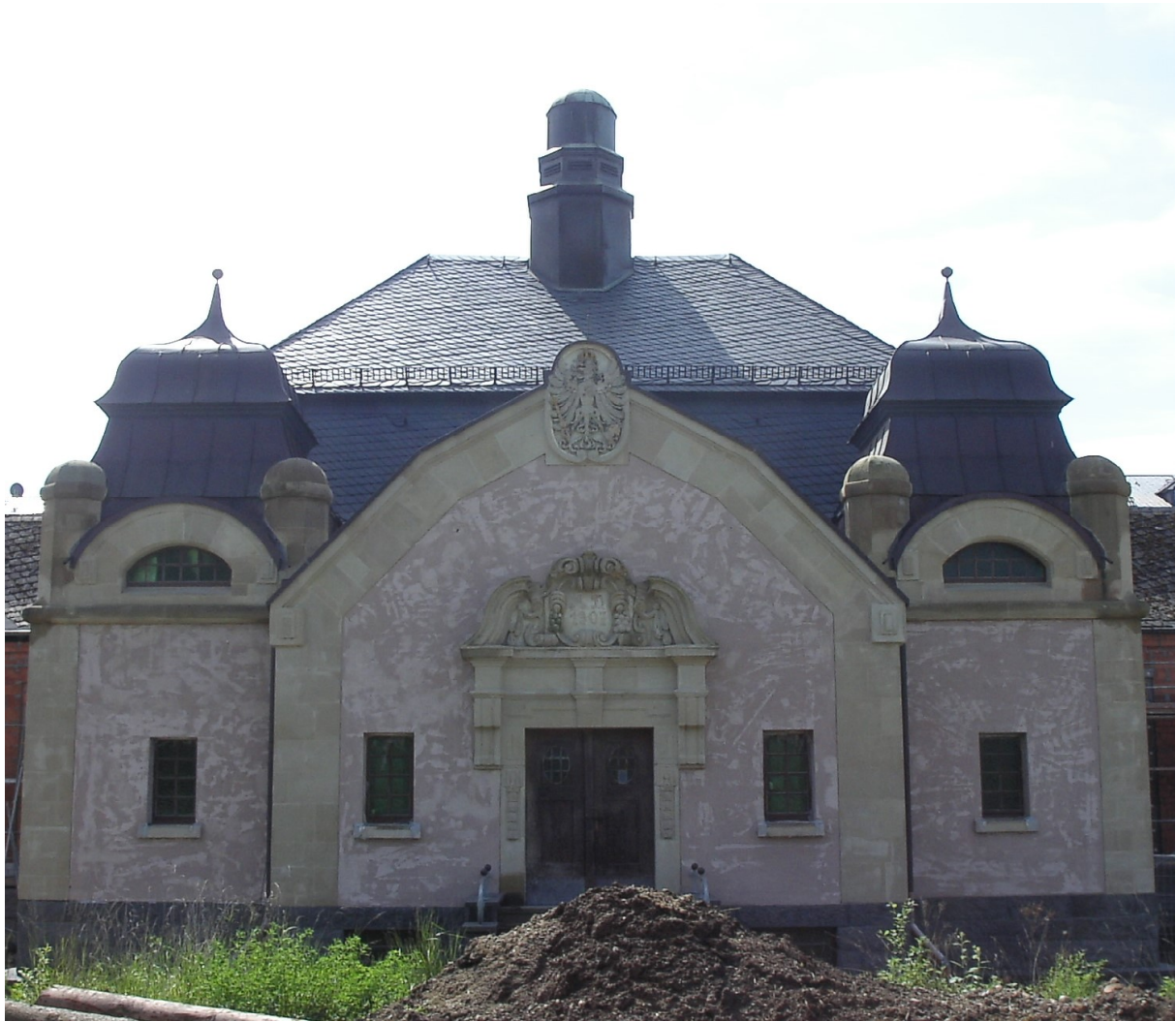
Das Niederselterser Brunnenhaus vor der Sanierung, errichtet um die Quelle herum aus der das Selterswasser jahrhundertlang in alle Welt versandt wurde.
