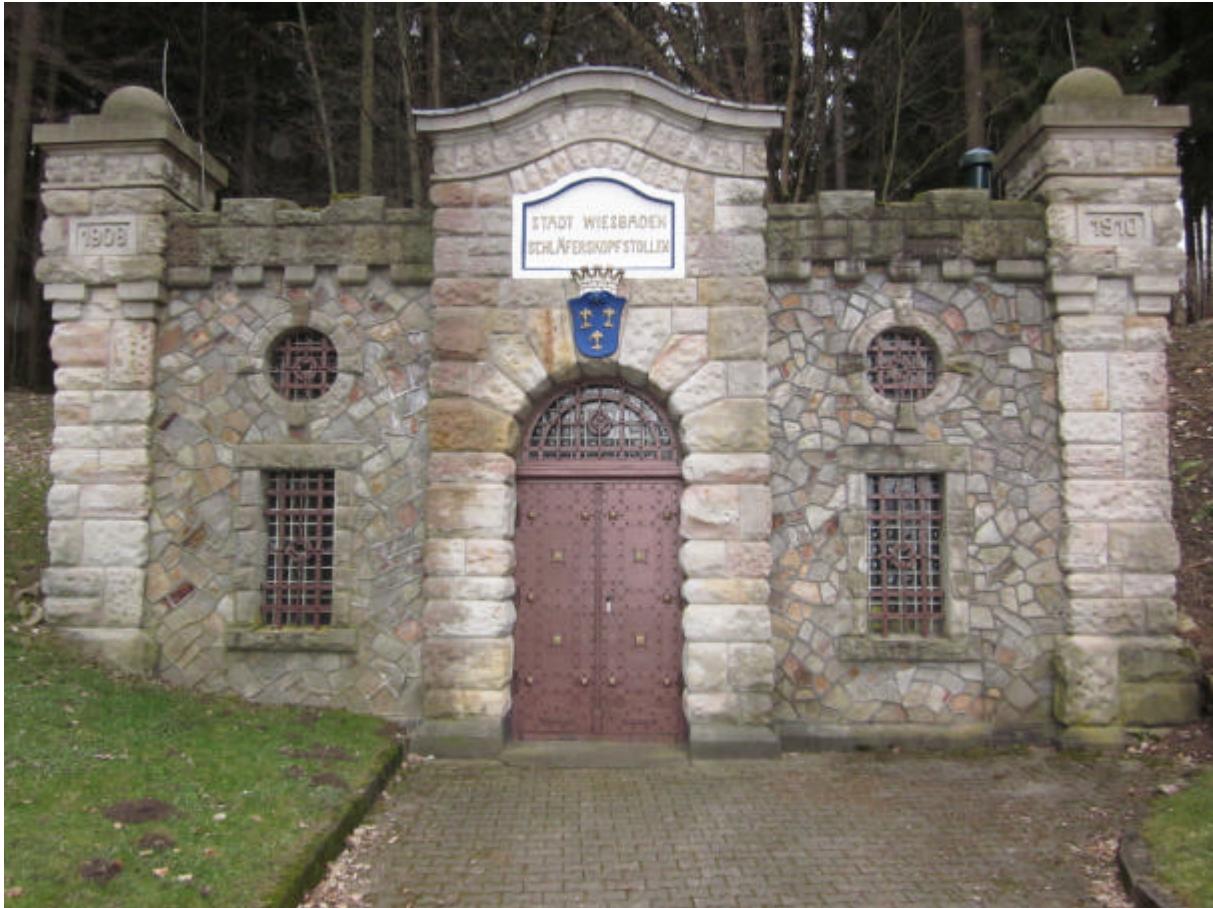
Eingang zum Schäferskopfstollen, erbaut zwischen 1908 und 1910. Er dient der Trinkwasserversorgung für die Stadt Wiesbaden und wurde zur Grundwassergewinnung über 1000 m in den Taunusquarzit getrieben.
