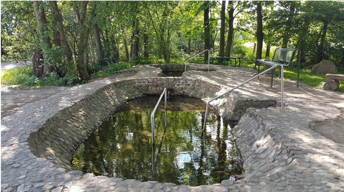
Die Quelle wurde als Wassertretbecken gefasst und fördert das Wasser durch natürlichen Druck des Grundwasserspiegels zutage.
